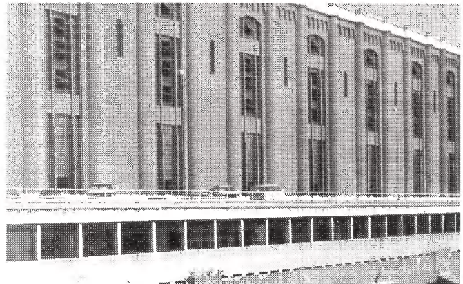
Les colonnes et le fenêtrage de la centrale de style gothique
