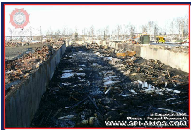
Les Jardins du Patrimoine, peu après l'incendie.
