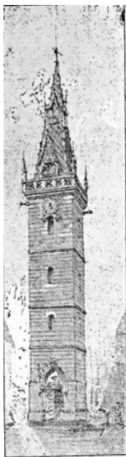
Fig. II. — BEFFROI DE SENLIS avant la restauration du XVIII e siècle.
